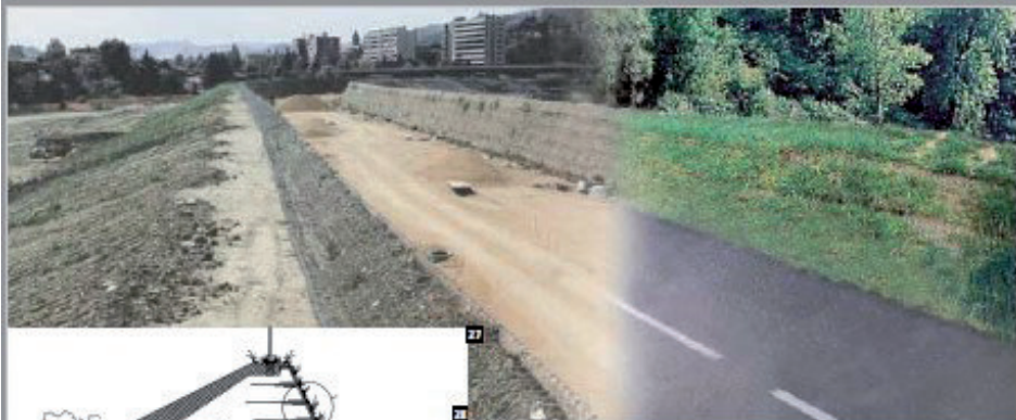
27-28. Barriera antirumore realizzata con elementi Terramash® verde nell'ambito di costruzioni stradali in ambiente urbano, Bologna-Italia.
