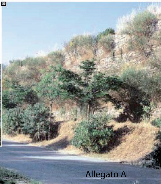
29-30. Barriera antirumore a proiezione di nuovo insediamento turistico, realizzata con elementi Terramash® S lungo la ferrovia Roma-Pisa, S.Vincenzo (LI)-Italia.
